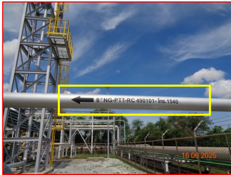
ภาพที่ 2-7 สัญลักษณ์แสดงตำแหน่งแนวท่อ โดยมีข้อความและหมายเลขโทรศัพท์แจ้งเหตุอย่างชัดเจน
