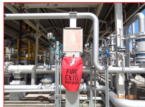
ภาพที่ 2-8 อุปกรณ์ป้องกันการระเบิด (Explosion proof) บริเวณสถานีควบคุม
