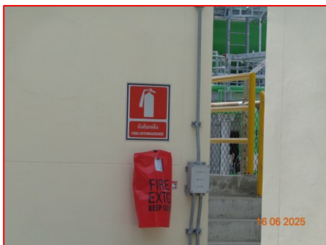
ภาพที่ 2-8 อุปกรณ์ป้องกันการระเบิด (Explosion proof) บริเวณสถานีควบคุม
