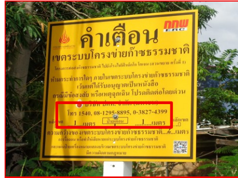
ภาพที่ 2-7 สัญลักษณ์แสดงตำแหน่งแนวท่อ โดยมีข้อความและหมายเลขโทรศัพท์แจ้งเหตุอย่างชัดเจน
