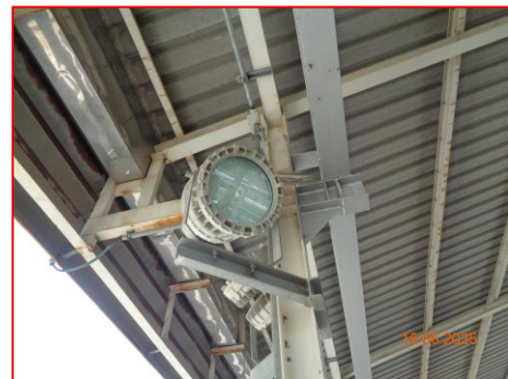
ภาพที่ 2-8 อุปกรณ์ป้องกันการระเบิด (Explosion proof) บริเวณสถานีควบคุม
