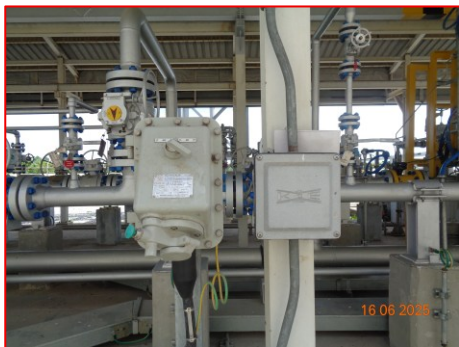
ภาพที่ 2-8 อุปกรณ์ป้องกันการระเบิด (Explosion proof) บริเวณสถานีควบคุม
