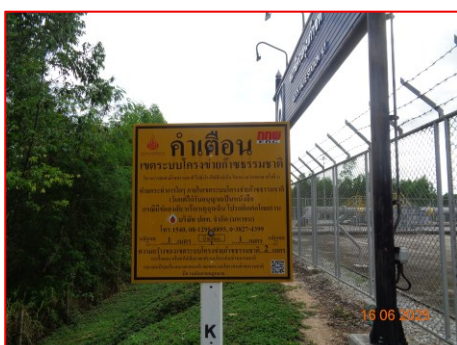
ภาพที่ 2-6 ป้ายเตือน (Pipeline Markers)
