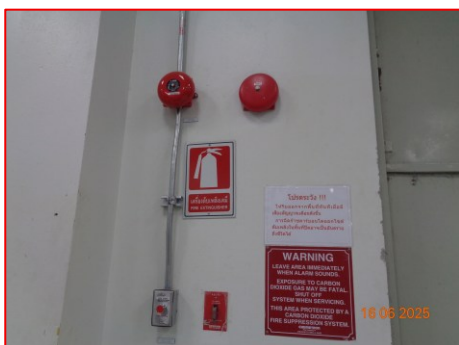
ภาพที่ 2-9 อุปกรณ์แจ้งเตือนและระงับเหตุอัคคีภัย
